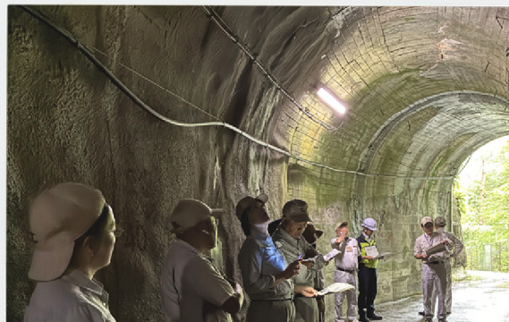
村道長野長島線3号トンネル修繕工事
