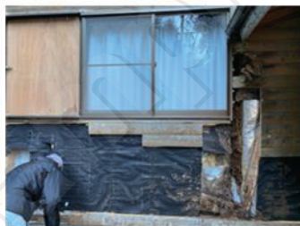
売店の壁シロアリ被害工事
