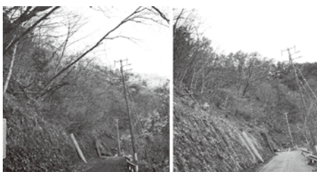
天龍村活用事例 (支障木の伐採)
