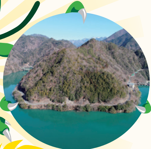
羽衣崎橋・平岡ダム
