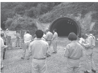
◀福島トンネル福島側坑口
