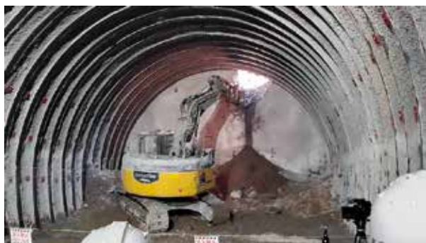
重機が岩肌を掘削し貫通
