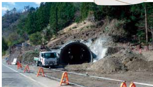
福島区側から見た坑口
