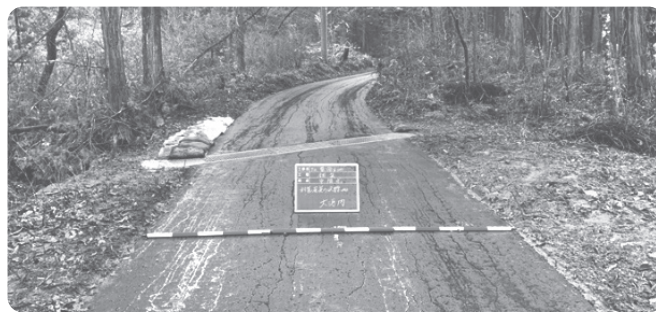
村道尾美の沢線他舗装工事
