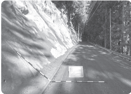
村道天竜川線法面防災工事
