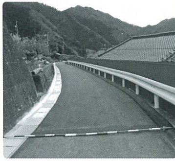
村道原大久保線舗装工事
