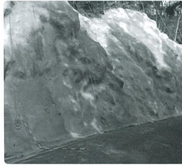
村道天竜川線法面防災工事
