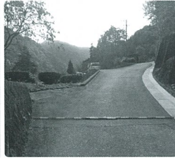
村道原清水線舗装工事
