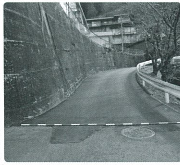
村道長野大嵐線舗装工事
