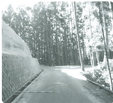
村道天竜川線法面防災工事
