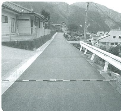
村道原大久保線舗装工事
