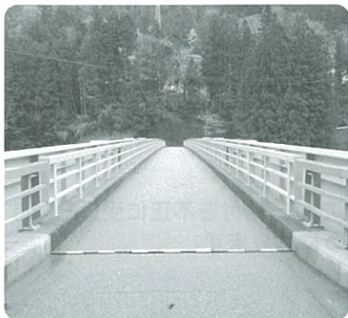
村道折立線橋梁維持修繕工事
