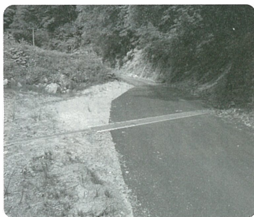
新しく設置した横断側溝(大久那田島線)
