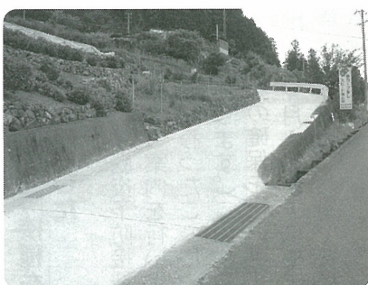
舗装と側溝の修繕(下山上線)
