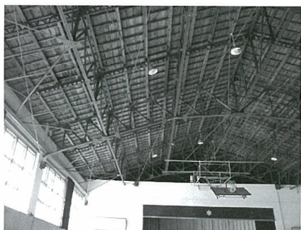
中学校体育館の耐震補強工事
