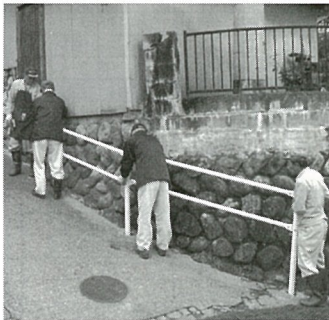
手すり設置(長野区板倉良三さん宅前)
