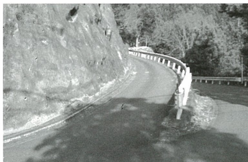
村道十久保線起点付近
