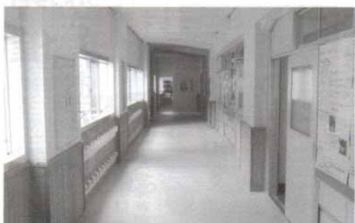
2階耐震壁設置に伴う廊下改修状況
