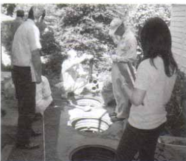
浄化槽パトロール
