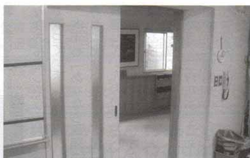
保健室耐震壁設置状況
