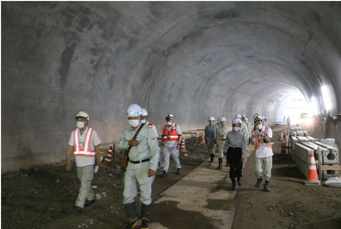
足瀬のトンネルは歩いて戸口側へ。トンネル用の円形水路（側溝）など内部の工事が進められています。
