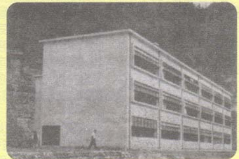
統合中学校舎(現天龍中)竣工
