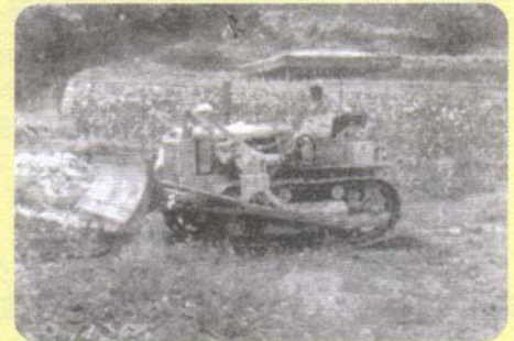
総合グラウンド(現天龍中グラウンド)新設
