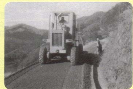
大幹線林道天竜川線(中井侍地籍)
